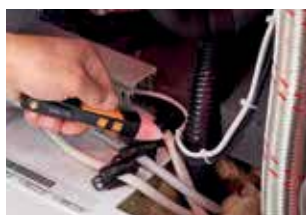
Premier contrôle de l'alimentation en tension d'un compresseur.
