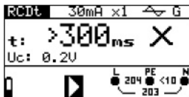
Test de Disjoncteurs
